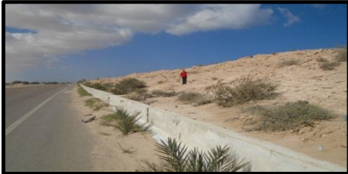
صورة (١٢) التفكك الكتل والانهيار الحبيبي للتكوينات الصخرية فى الحجر الجيري الأوليتى على المنحدرات الجنوبية لطريق إسكندرية - مطروح بمنطقة شرق الضبعة بين دائرتى عرض ٦° 31 02 ، ٣٠° 31 01 ش ، دائرتى عرض ٢٤° 28 29 ، ١٢° 28 28 ق - إتجاه التصوير صوب ج.ق
