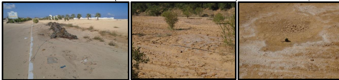
صورة(٢٥) أثر التجوية الملحية في تدمير أشجار النخيل بمنطقة غرب الضبعة - إتجاه التصوير صوب
