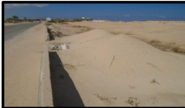
صورة (٨) تهديد حركة الكثبان على الطرق بمنطقة سيدى عبدالرحمن بين دائرتي عرض 30^{\circ}59'09'' ، 30^{\circ}59'09'' ش ، وخطي طول 28^{\circ}41'28'' ، 28^{\circ}41'28'' ق - لاحظ سفى الرمال المنقولة من الكثبان المتحركة باتجاه الطريق - إتجاه التصوير صوب الجنوب الغربى.
