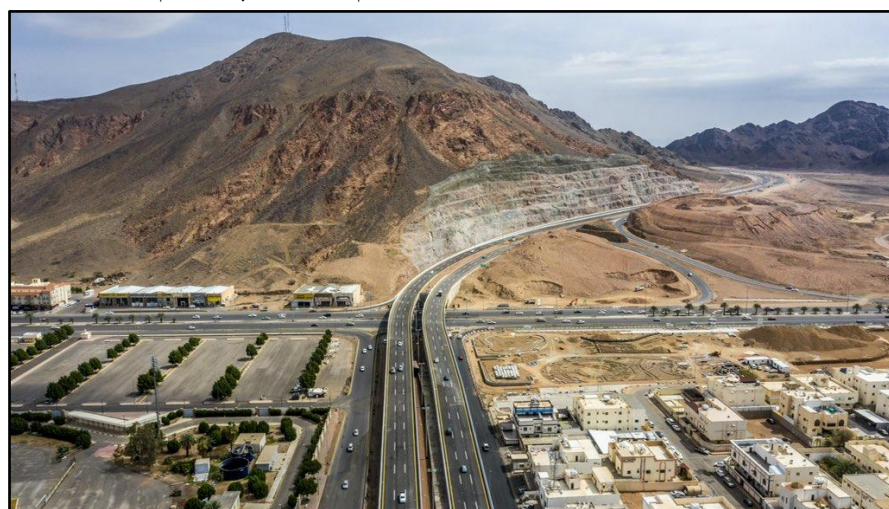
صورة (٣) جسر طريق الأمام مسلم لربط أحياء بلدية قباء جنوب المدينة بأحياء بلدية البيداء غرب المدينة المنورة عام ١٤٤٢هـ/٢٠٢٠م
