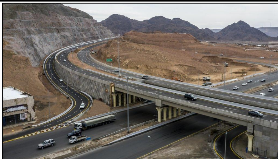
صورة (٢) جسر طريق الأمام مسلم لربط أحياء بلدية قباء جنوب المدينة بأحياء بلدية البيداء غرب المدينة المنورة عام ١٤٤٢هـ/٢٠٢٠م
