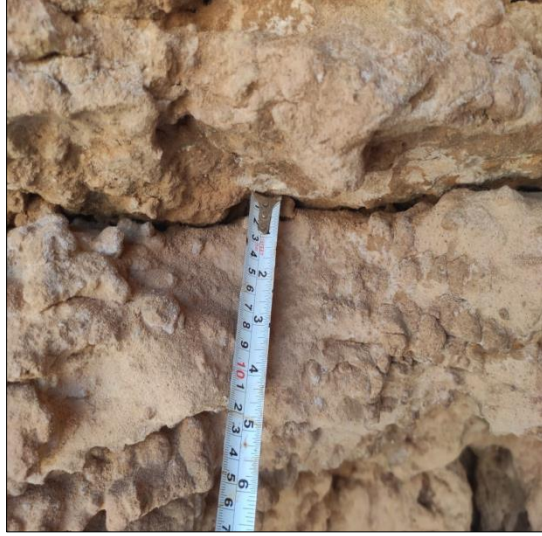
المصدر: العمل الميداني في المدة من ٥ - ٨ أغسطس ٢٠٢٢ كهف ٩ ٣١ ٣٧ ٣٣ ش ٢٥ ٥٥ ٢٧.٧٧" صورة (١٠) إتساع الفواصل بفعل التجوية الميكانيكية والكيميائية على صخور الكهوف
