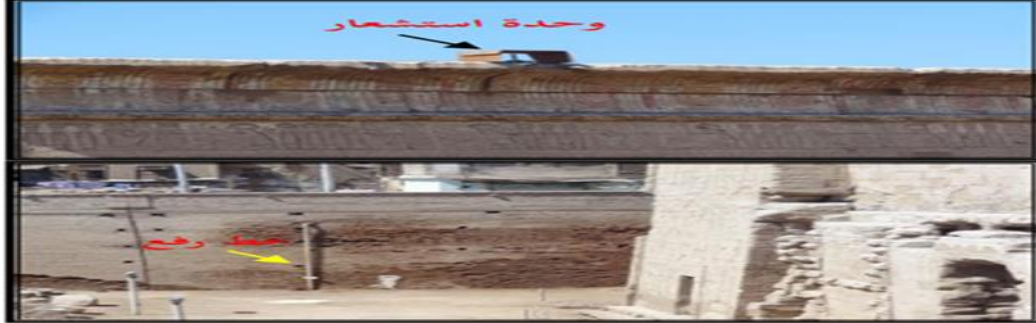
شكل (٣٦) وحدة استشعار وخط رفع للمياه الجوفية أسفل معبد إسنا.
