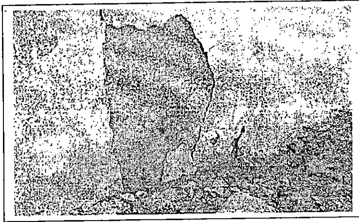
صورة رقم (٢) ظهور التجويفات والحزوز على أساسات المباني ناظرا صوب الجنوب
